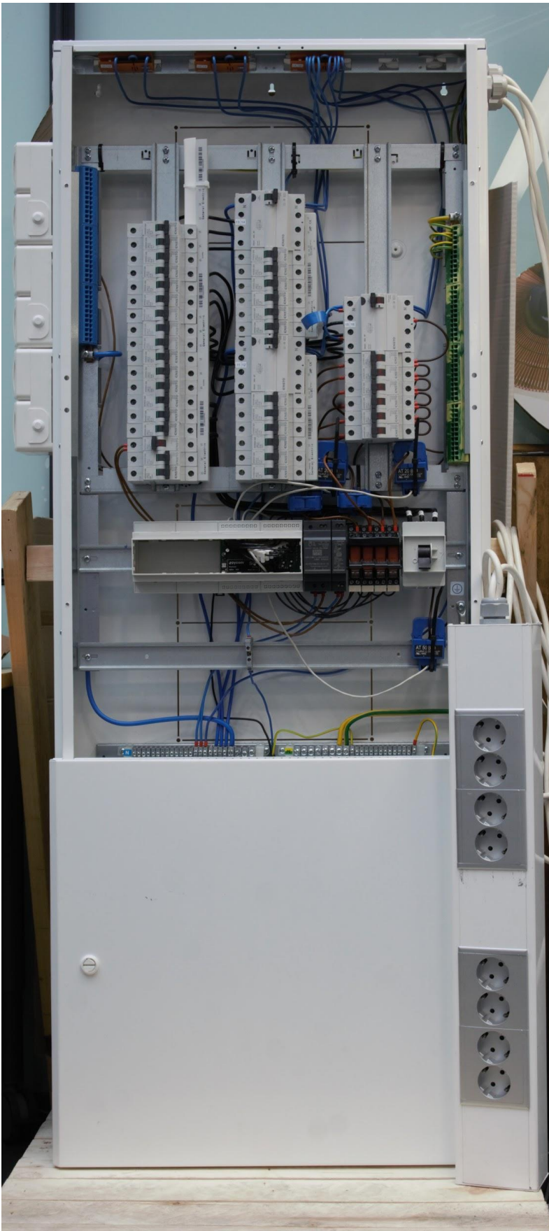
kuva 10. Sähkökeskus projektin valmistuttua
